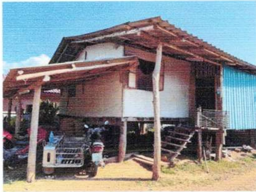
ภาพถ่ายก่อนปรับปรุงสภาพบ้านผู้พิการ
